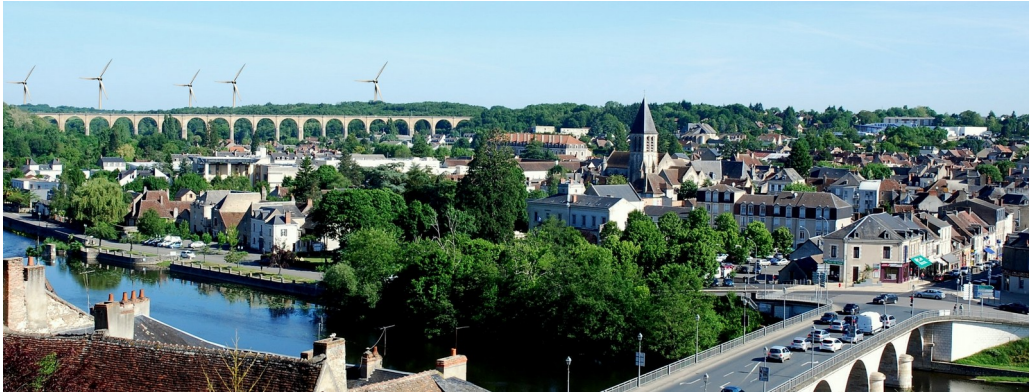
Vue du Château Naillac
